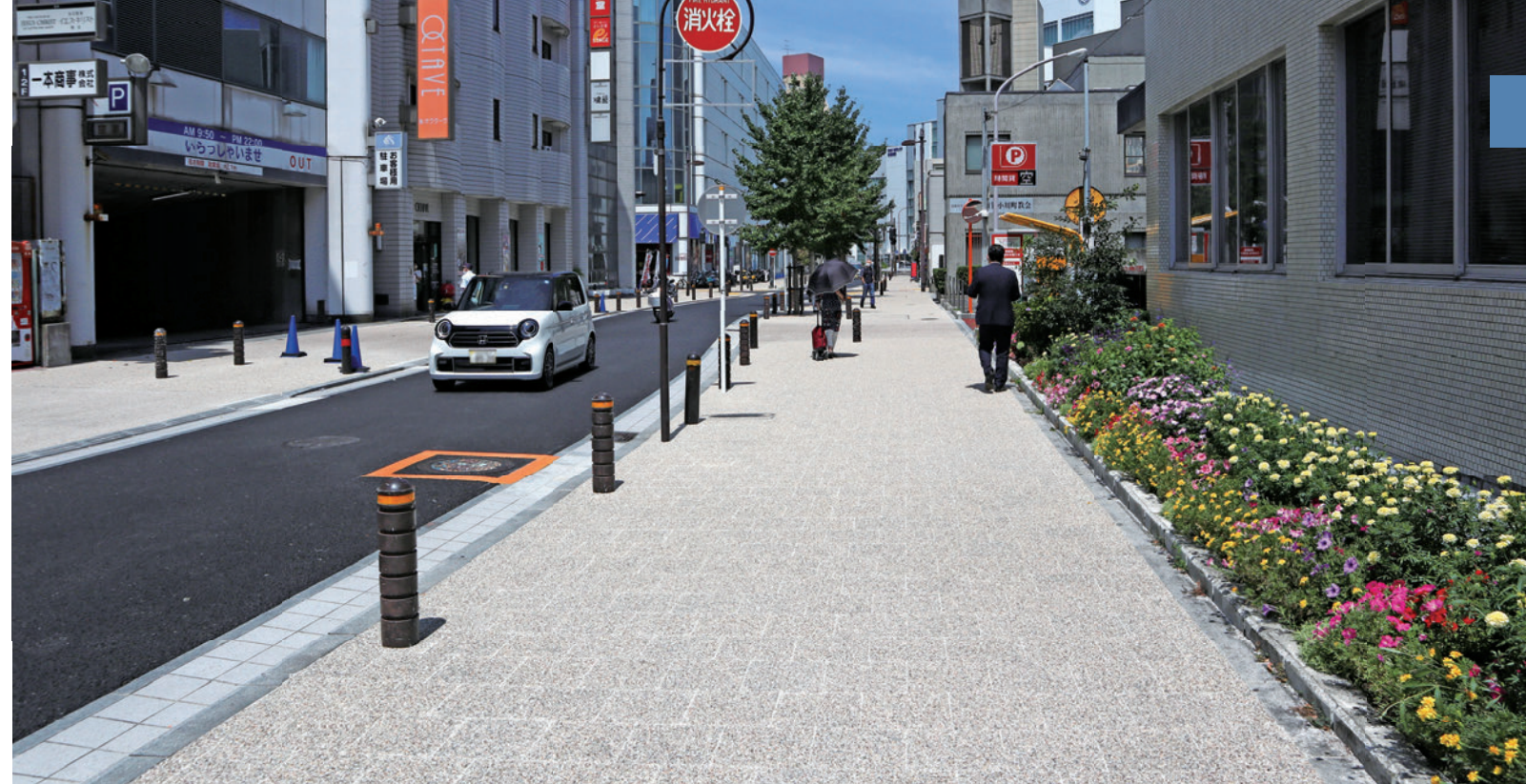
市道573号線(神奈川県横須賀市)
