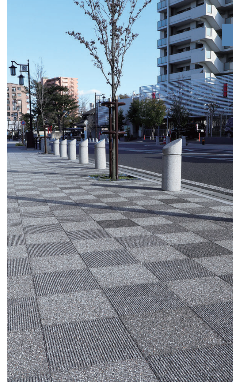
刈谷銀座線(愛知県刈谷市)
