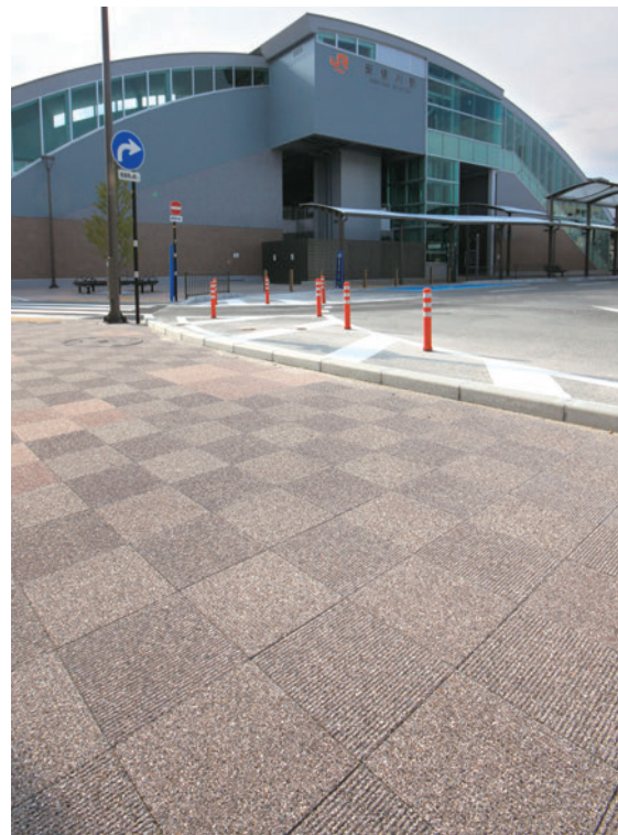
安倍川駅東口駅前広場(静岡県静岡市)
