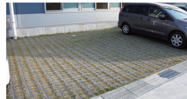
(株)静岡制御 本社工場(静岡県静岡市)／グラスインター
