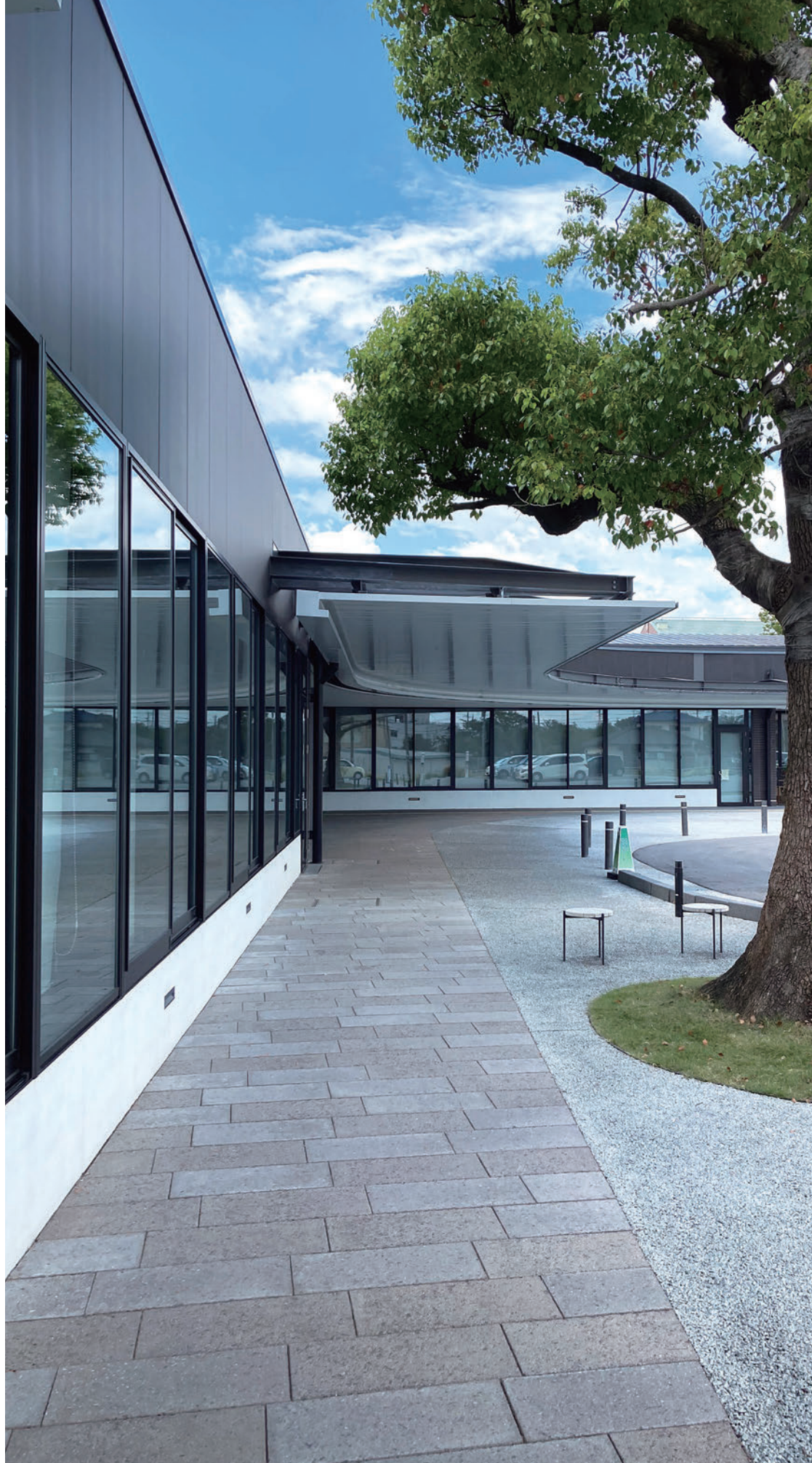
みやま市総合市民センター MIYAMAX(福岡県みやま市)
