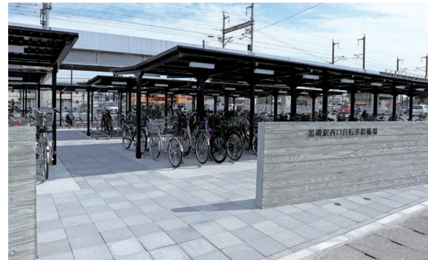
黒磯駅西口自転車駐輪場(栃木県那須塩原市)
