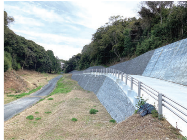
大坂沢砂防堰堤 (静岡県掛川市)
