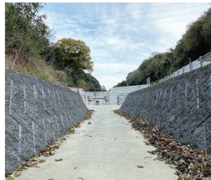
大坂沢砂防堰堤(静岡県掛川市)
